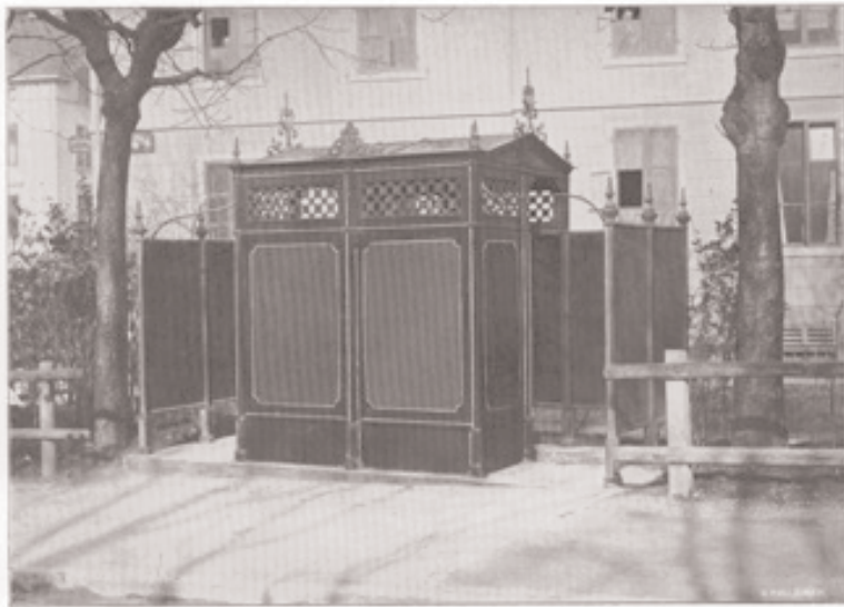
◀ Freistehendes historisches Pissoirhäuschen
